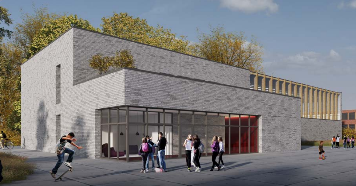
Herne | Multifunktionshalle Hölkeskampring
